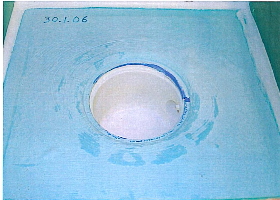
Kuva 1. Purus lattiakaivo/Kiilto Kerafiber vedeneriste/Kiilto Kaivolaippa: koekappale kaivokokeen jälkeen.
